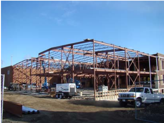
Structural Steel at Commons
